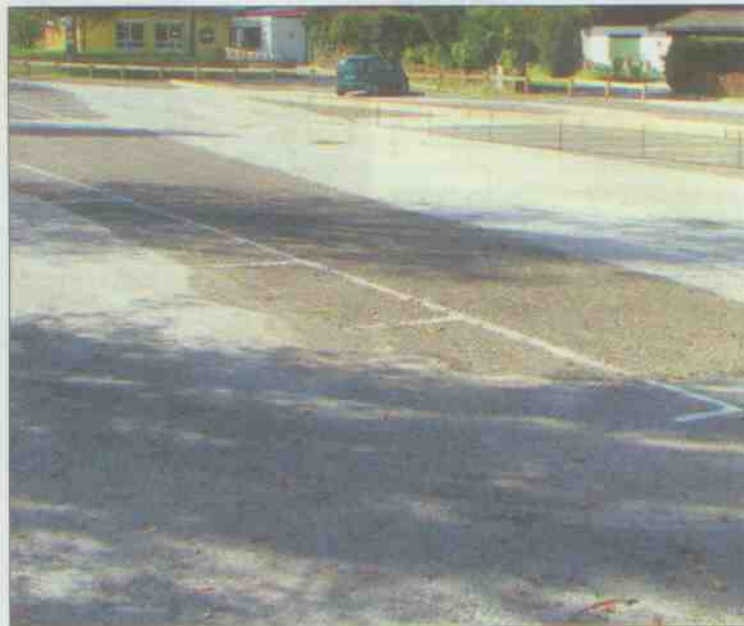
Der neue Parkplatz am Verkehrskindergarten bietet genügend neue Stellplätze, sowohl für Kurz- als auch Dauerparker. Bild: SW/BRINEK
